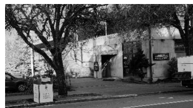
Здание правоохранительных органов (Law Enforcement Building) Рядом со входом с улицы 5th St 180 NW 5th St Corvallis, OR 97330
